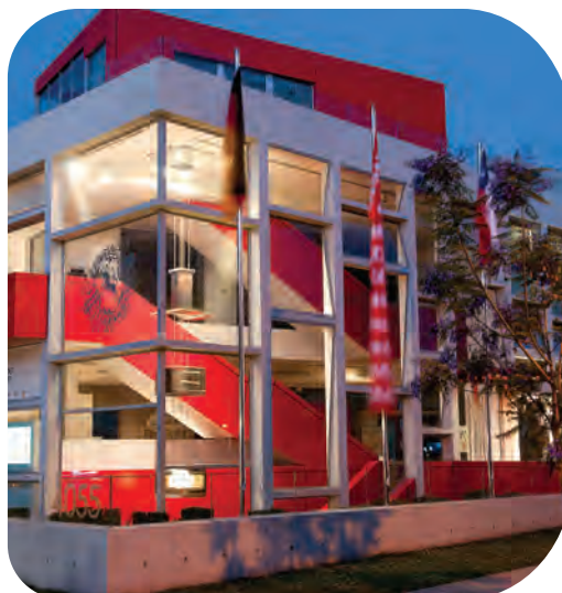
Cool – Lite SKN 174 Showroom Miele Arquitecto: Gonzalo Mardones V.
